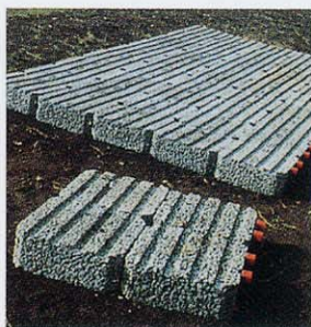
緑化ブロックを敷設した状況
