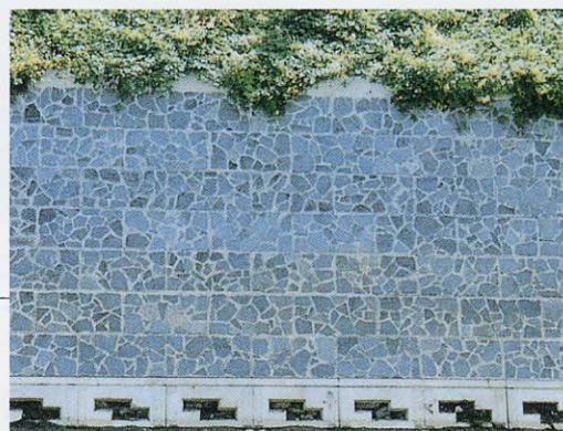
オストマテラス積ブロック
